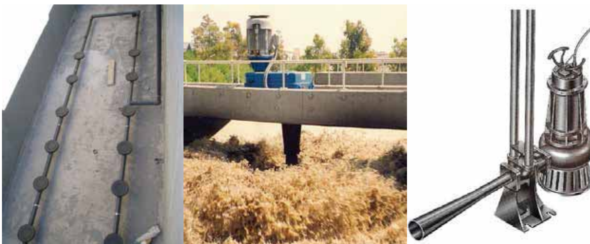
Figura 5.5.4. Sistemas de aireación: difusores, turbina y eyectores tipo Venturi
