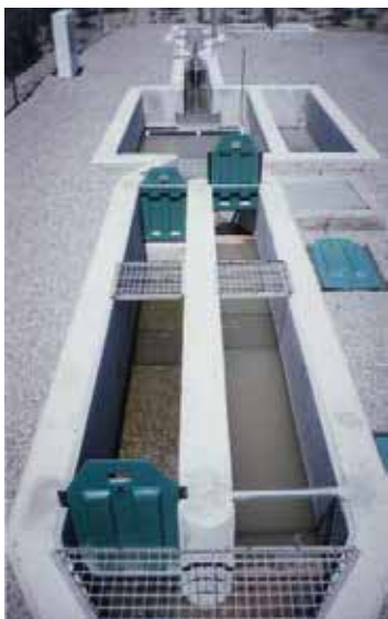
Figura 4.5. a) Desarenador estático de doble canal; b) Esquema de desarenador aireado
