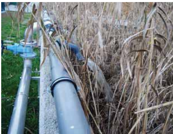
Figura 7.10. Alimentación de un humedal para lodos. EDAR de Santa Eulalia de Ruiprimer (España)
