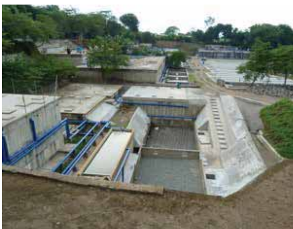
Figura 2.6. PTAR de Villa Lourdes, mediante RAFA + FAFA.
