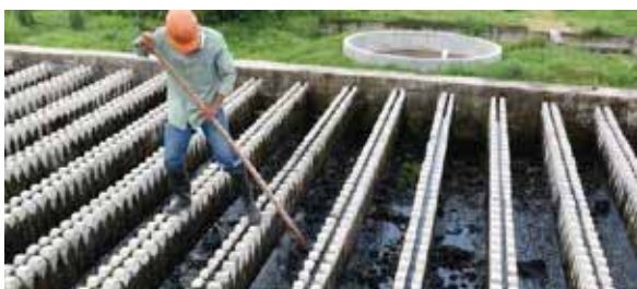
Figura 8.6. Labores de mantenimiento en un filtro percolador
