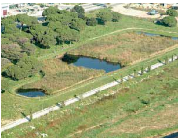
Figura 6.8. Humedal Artificial de Flujo Superficial en cola de un tratamiento (Granollers, Barcelona, España)
