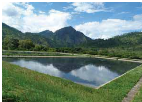
Figura 5.3.1. Sistema de lagunas en Danli (Honduras)
