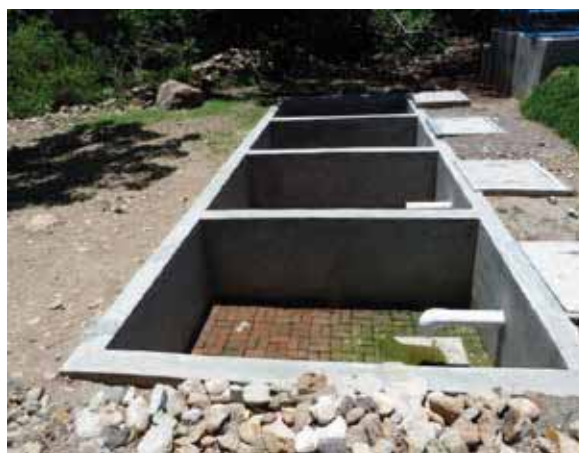
Figura 7.7. Izq: Patios de secado de las PTAR de San Juan Opico (El Salvador); Dch: PTAR de Colonia Tatumbla (Honduras)
