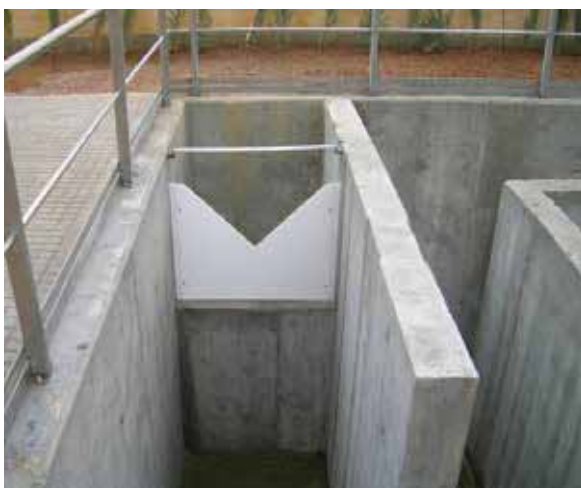
Figura 4.8. a) Medida en vertedero triangular; b) Medidor magnético en tubería
