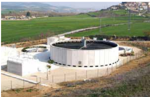
Figura 5.1.3. Filtro percolador circular con distribución móvil
