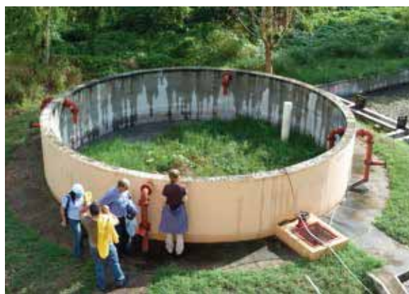
Figura 3.5. Digestor anaerobio abierto a temperatura ambiente
