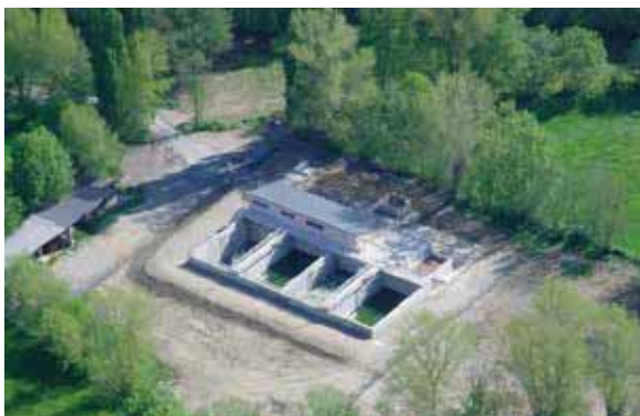
Figura 5.5.8. Sistema SBR de la PTAR de Alp (España)
