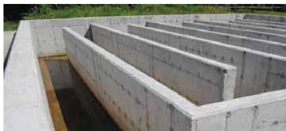
Figura 6.6. Laberinto de cloración
