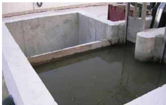
Figura 4.1. Obra de llegada y aliviadero
