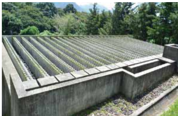
Figura 5.1.4. Filtro percolador rectangular con distribución fija
