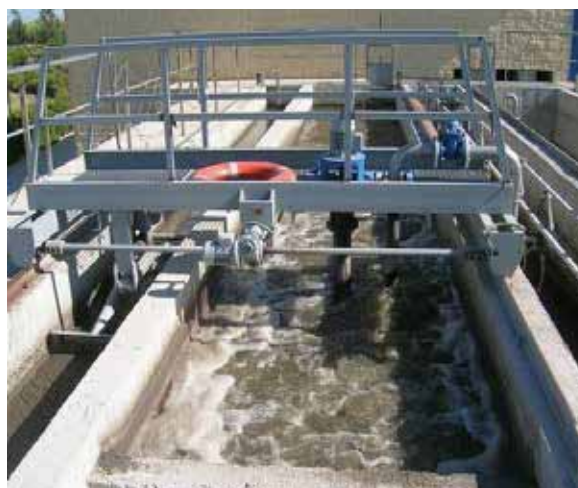
Figura 4.7. a) Desengrasador estático; b) Desarenador-desengrasador aireado
