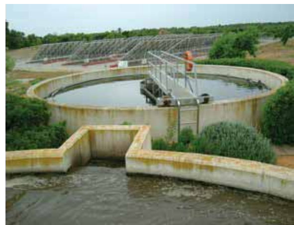
Figura 5.5.6. Sedimentadores secundarios: a) circular estático, con flujo vertical y b) circular con rasquetas y puente móvil
