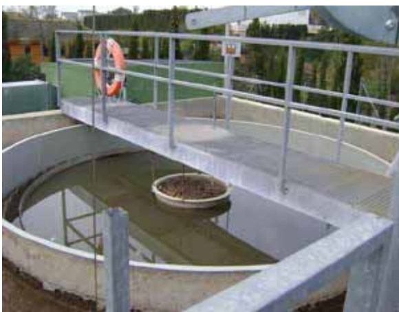
Figura 5.5.6. Sedimentadores secundarios: a) circular estático, con flujo vertical y b) circular con rasquetas y puente móvil
