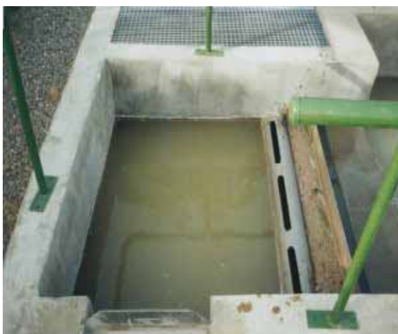
Figura 4.7. a) Desengrasador estático; b) Desarenador-desengrasador aireado
