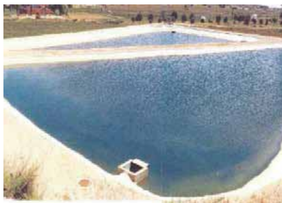
Figura 6.7. Laguna de maduración
