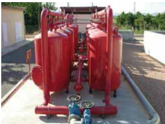
Figura 6.4 Filtros de arena: a) de gravedad y b) de presión
