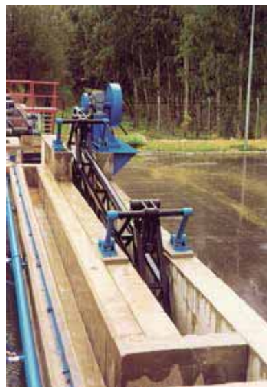
Figura 4.6. Separación agua-arena: a) Tornillo de Arquímedes y b) Clasificador alternativo
