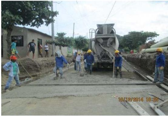
Fotografía 7: Vaciado de losa - pavimento
