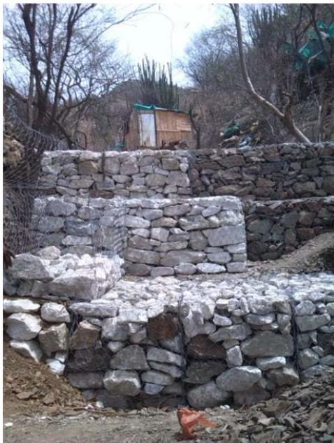
Fotografía 11: Colocación de capas de piedra
