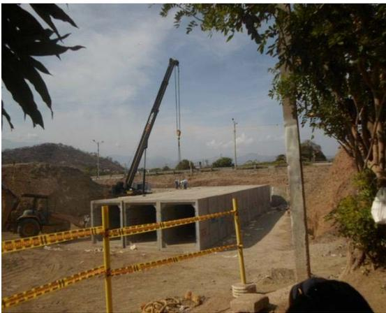
Fotografía 3: Colocación de Box Colver
