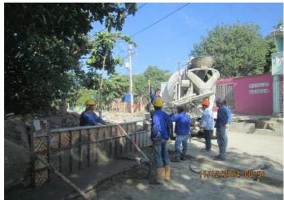
Fotografía 6: Colocación de formaletas para muros
