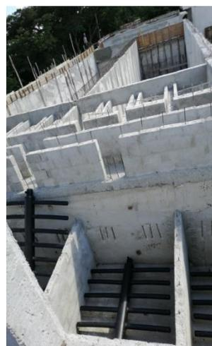
Fotografía 2: Coagulador-Floculador, Decantador y Filtros de arena Guisa
