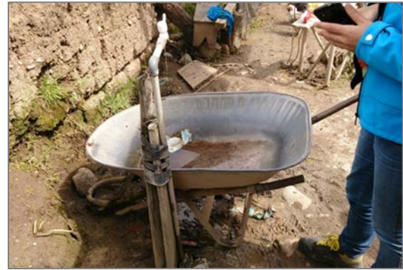
Fotografía 2: Estado actual de conexión domiciliar de agua potable, localidad 3 de Octubre
