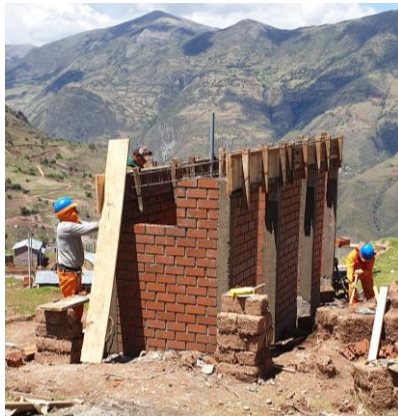
Casetas sanitarias centro escolar Cruzpampa 26 de noviembre de 2019
