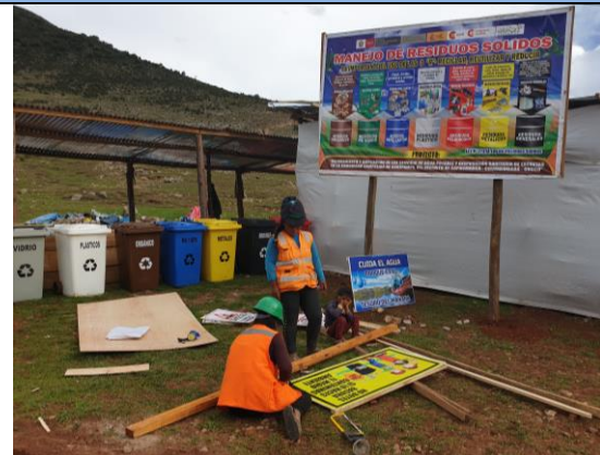
Gestión ambiental en la obra de Cruzpampa 26 de noviembre de 2019
