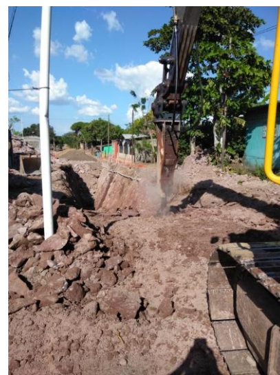
Foto 6: Apertura zanjas con martillo neumático
