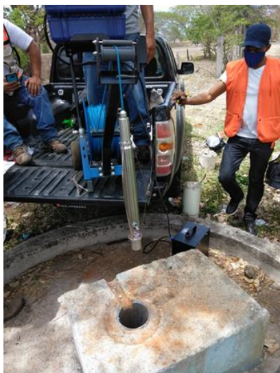
Foto 5: Desarrollo hidráulico en pozos perforados
