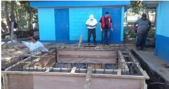
Foto 5. Mejoras en el cárcamo de bombeo de la EBAR Bosco Monje
