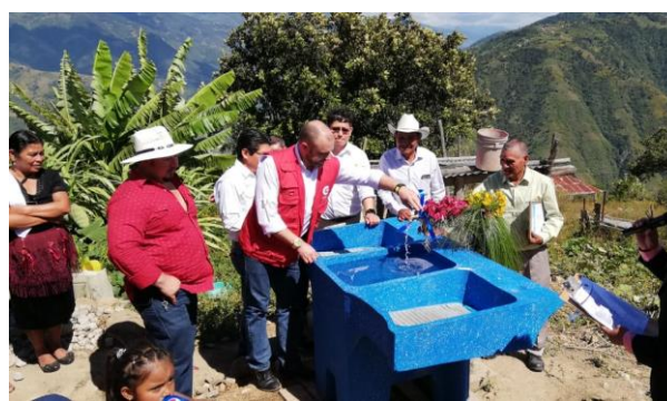
Fotografía 2: Conexión domiciliar de proyecto San Julián La Lucha
