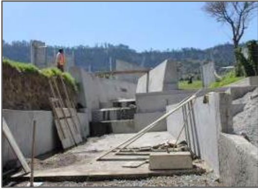
Fotografía 1: Construcción de sistema de Agua potable Fase II, Panajachel
