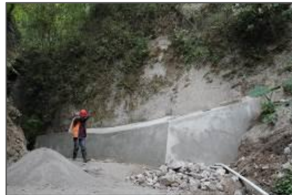
Fotografía 6: Construcción de sistemas de captación Pazots, Panajachel
