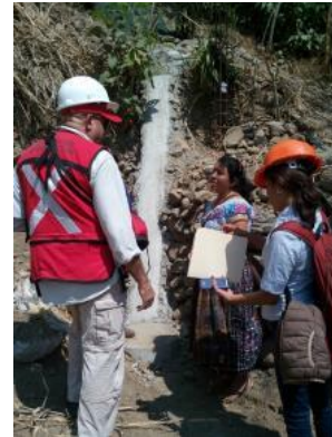
Fotografía 4: Certificación de sistema de Alcantarillado Condominial, Barrio 2. San Marcos La Laguna, Sololá.
