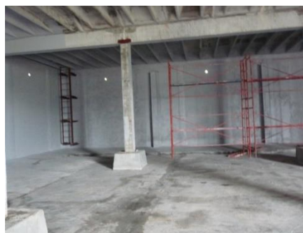
Fotografía 2: Impermeabilización Tanque de La Mañoca Guisa
