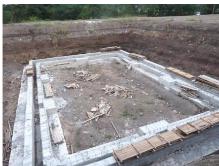
Fotografía 1: cimentación depósito PTAP Guisa
