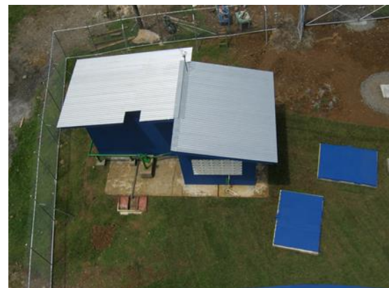
Fotografía 4: Vista de la caseta de bombeo desde tanque elevado. Acueducto Palmitas II. 10 de octubre 2014
