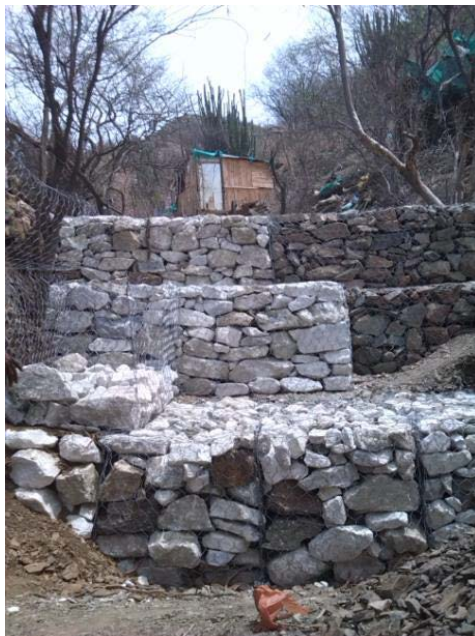
Fotografía 11: Colocación de capas de piedra
