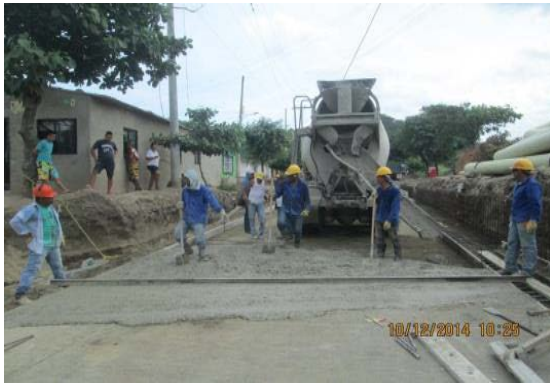
Fotografía 7: Vaciado de losa - pavimento
