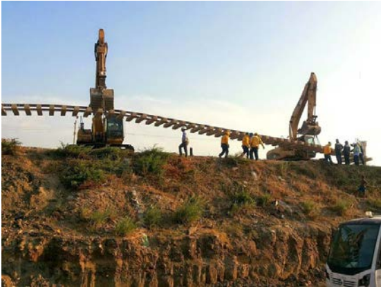
Fotografía 1: Retirada de vía férrea
