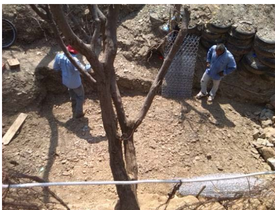
Fotografía 9: Preparación del terreno
