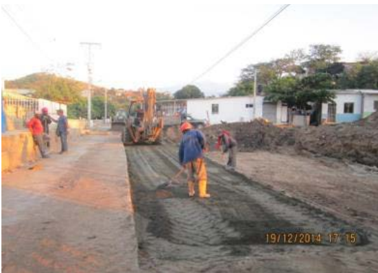
Fotografía 5: Conformación de suelo cemento como base de pavimento
