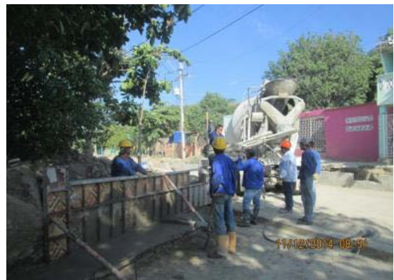
Fotografía 6: Colocación de formaletas para muros
