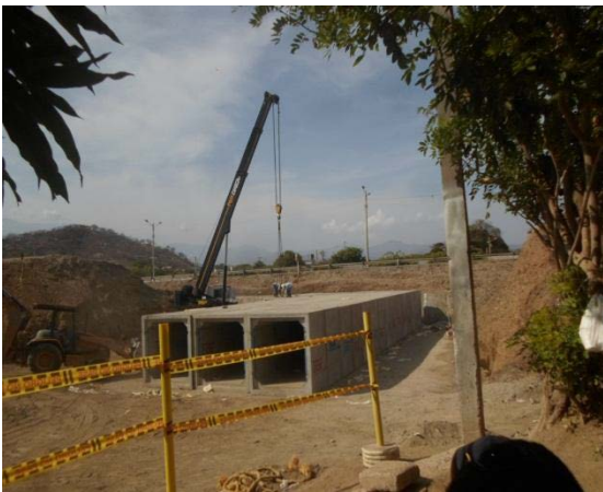
Fotografía 3: Colocación de Box Colver
