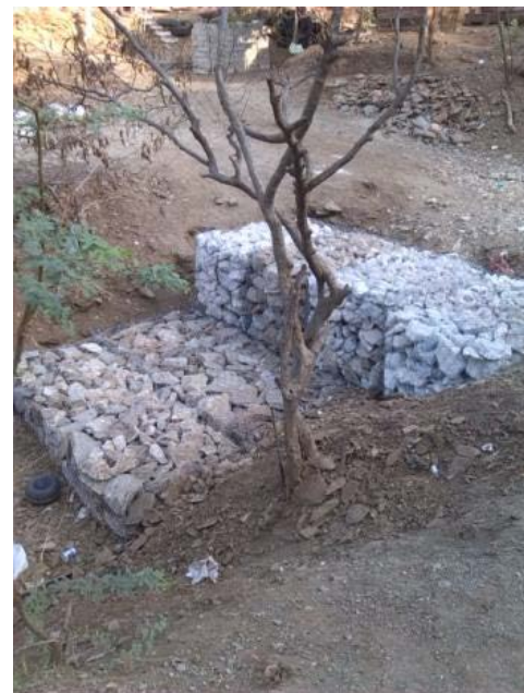
Fotografía 12: Presa antierosión concluida
