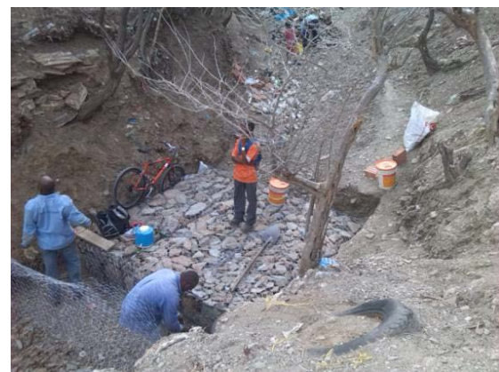
Fotografía 10: Asentamiento de piedra
