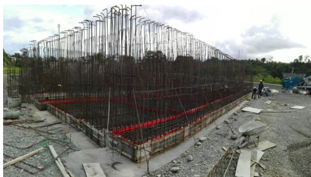
Foto 3: Trabajos en PTAP de Itsmina
