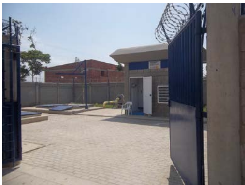
Fotografía 3: Instalaciones de la estación de bombeo red de alcantarillado barrio Nelson Mandela
