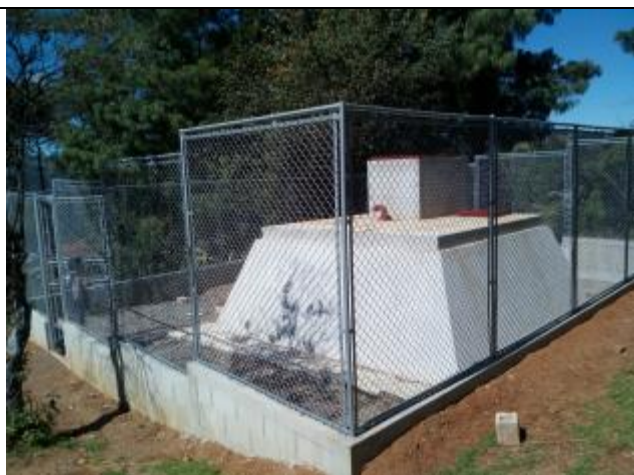
Fotografía 3: Recepción de sistema de Agua y Saneamiento (Tanque de Distribución) en Caserío Belen Cancela, Municipio de San Miguel Ixtahuacan, Departamento de San Marcos.
