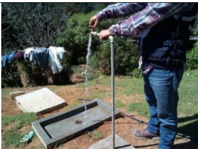
Fotografía 4: Recepción de sistema de Agua y Saneamiento (Conexión domiciliar) en Caserío Belen Cancela, Municipio de San Miguel Ixtahuacan, Departamento de San Marcos.
