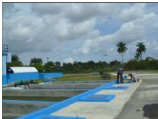
Fotografía 5: Lechos de Secado Mantilla
