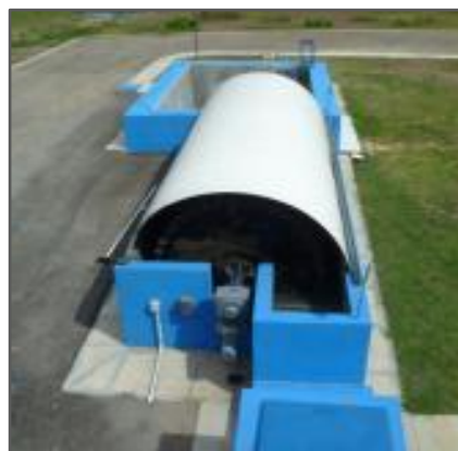
Fotografía 4: Biodiscos Mantilla
