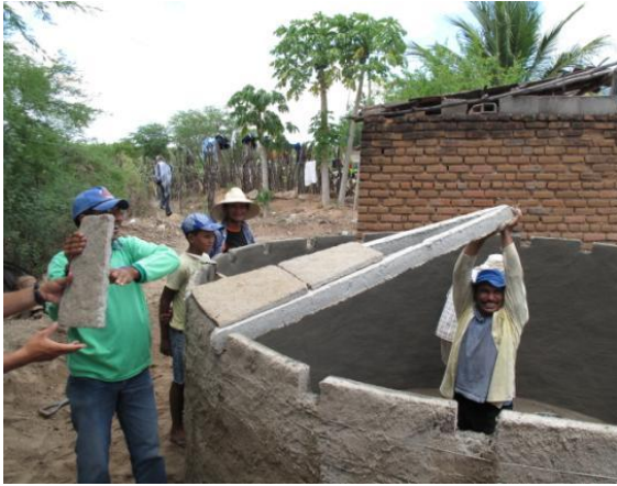
Proceso de construcción de una cisterna
